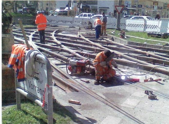
Magic Weld, die mobile Schweißanlage, in einem typischen Einsatzgebiet.
